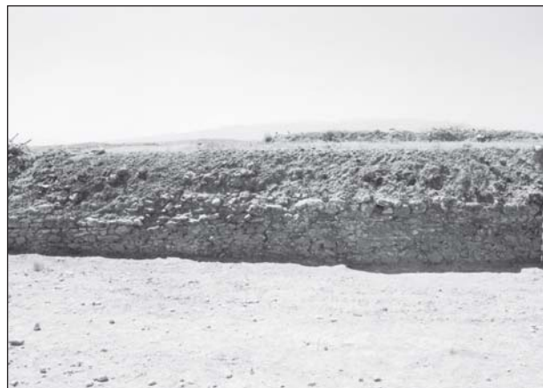
Figura 8: Aparejo del muro de cierre ala Norte.
