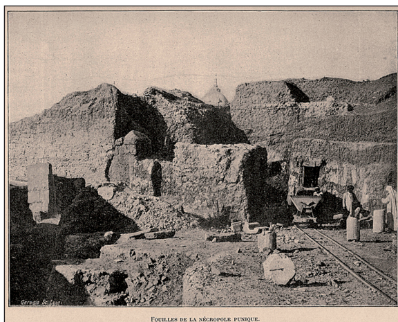
Figura 3. Excavaciones de los Pères Blancs en la necrópolis. Se aprecian las vagonetas “Decauville”.
