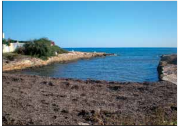
Varadero excavado en la roca. El Estacio.
