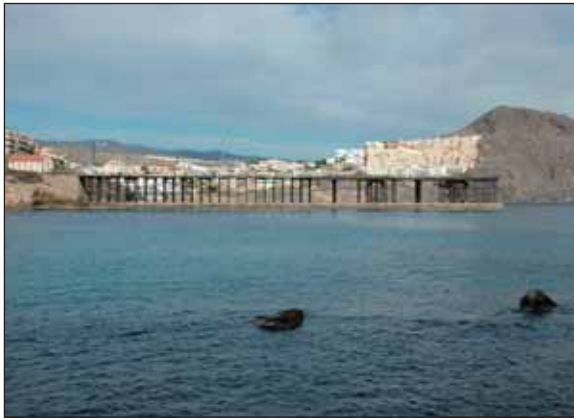
Muelle de descarga de mineral. El Hornillo. Águilas.
