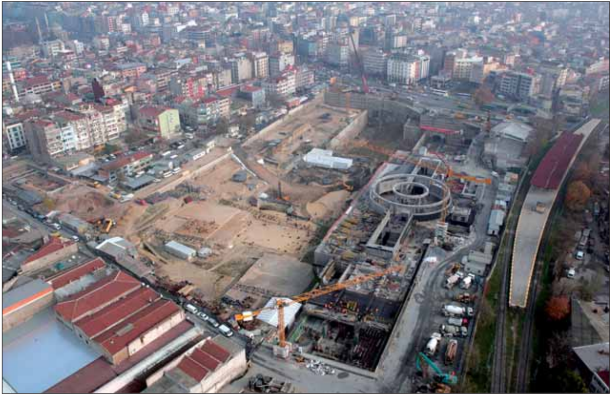
Avance de las obras del transfer point de Yenikapi, en el momento en que fue convocado el concurso internacional de arquitectura, con el objetivo de crear un parque arqueológico y de reordenar las áreas limítrofes (2011).
