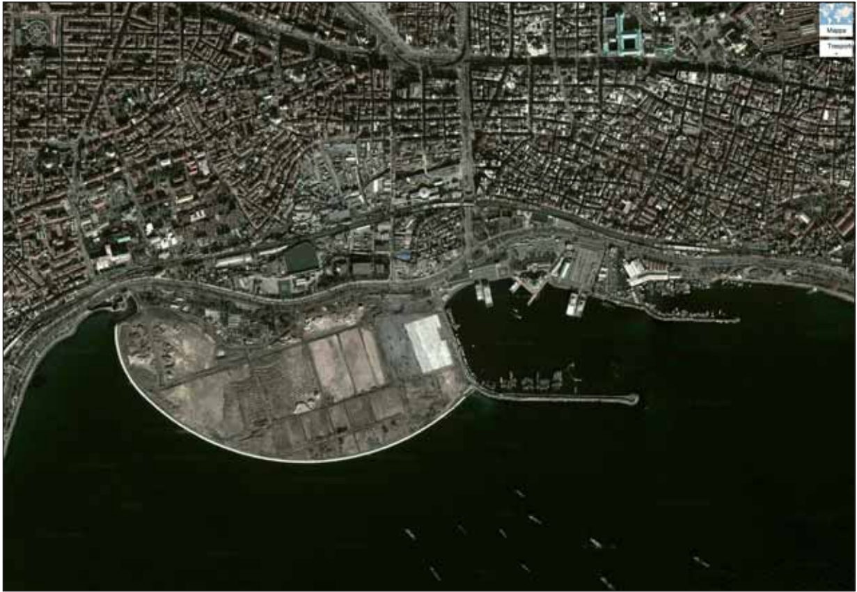
Foto actual del área con las obras que han modificado radicalmente la línea de tierra, sin tener en cuenta el resultado del concurso.
