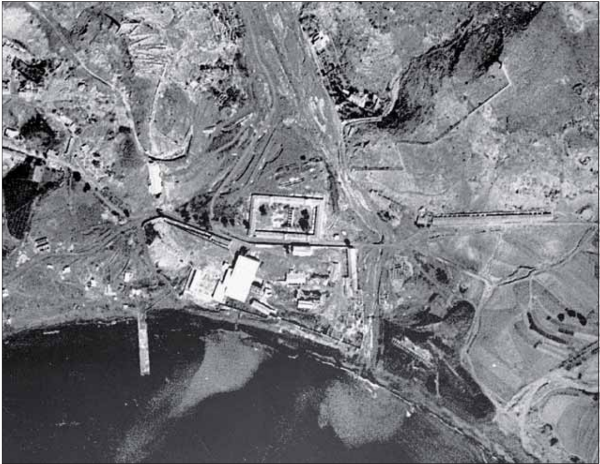
Ilustración 4: Instalaciones del Lavadero Roberto y su entorno. Ortofoto de 1956. Fuente: Cartomur.
