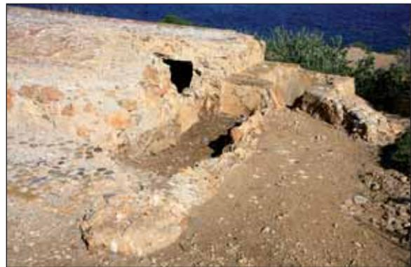
Trazado de la boquera desde la vivienda donde se recogen las aguas de lluvia; abajo, entrada de agua al aljibe con el “repositor” en la esquina y, en el centro, el acceso para sacar el agua.
