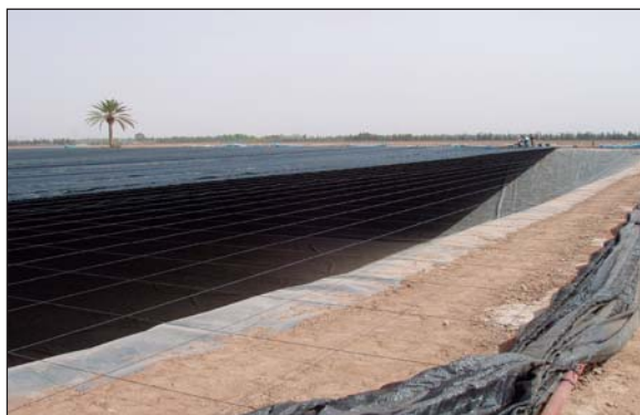
Figura 4. Instalación de la cobertura de sombreo suspendida ATARSUN.
