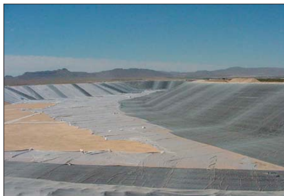
Figura 2. Balsa en construcción. Instalación de la geomembrana.
