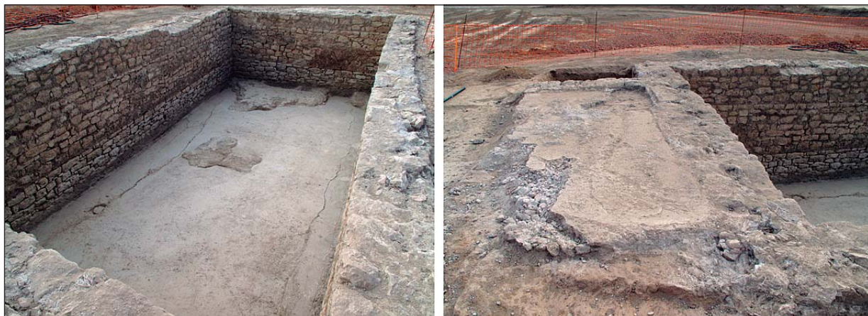
Lámina 5. Cisterna de Los Morenos (EHA 2). A la izquierda, vista interna del depósito desde el vértice norte, con suelo de signino y fábrica de mampostería construida con tres cuerpos escalonados; a la derecha, depósito de decantación o aclarador ( piscina limaria revestida con opus signinum ) adosado a la cara septentrional de la cisterna.
