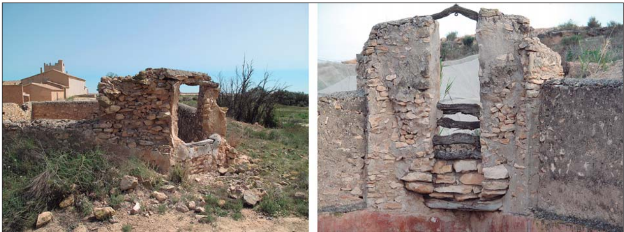
Lámina 9. Estructuras acondicionadas para extraer agua desde un vértice de la balsa. A la izquierda, Caserío La Torrica; a la derecha, Casa del Peretico (El Hondón).
