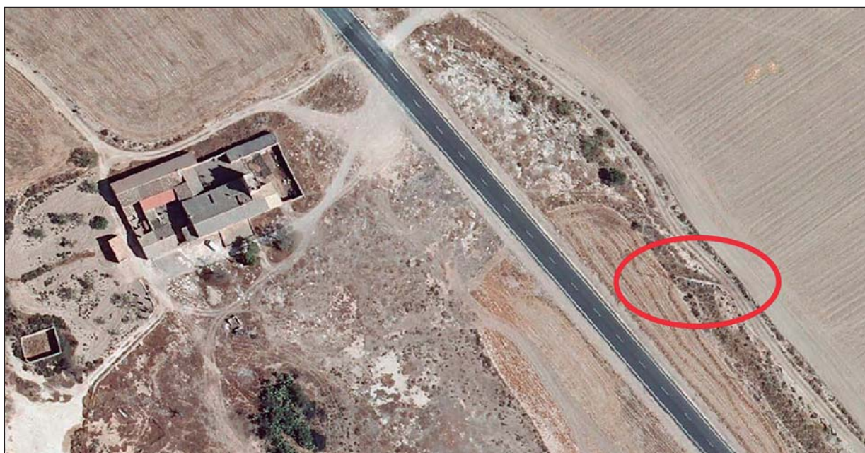
Lámina 7. Vista aérea del azud de tierra localizado en la rambla de Corvera a su paso por Casa La Torrica. Obsérvese su disposición oblicua al cauce para derivar agua hacia la boquera-camino en el tramo final del sistema de regadío (Fuente: http://www.cartomur.com ).
