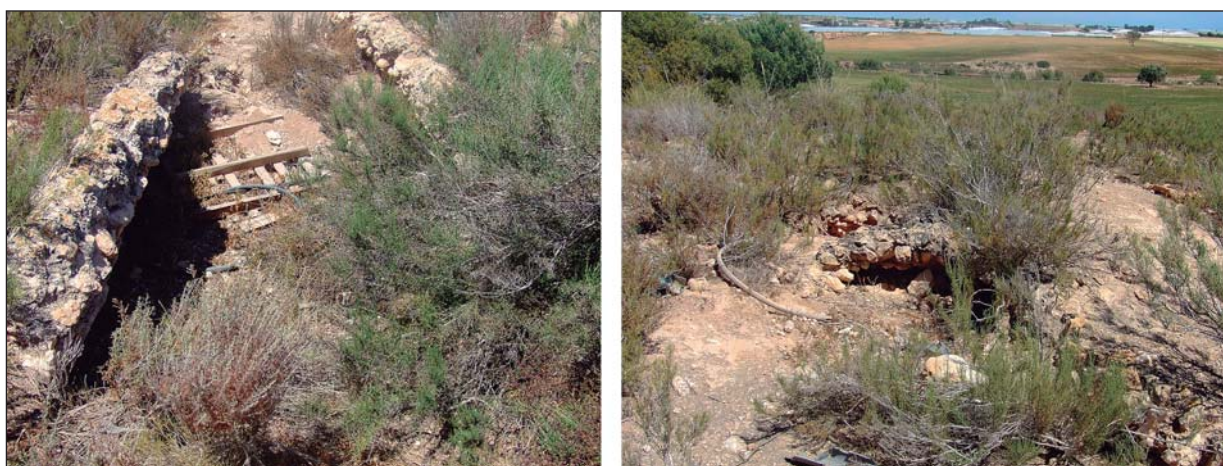
Lámina 6. Las Covaticas/Casa Blanca. Estado actual de las bóvedas de cañón que cubren las cisternas rectangulares revestidas, interiormente, con opus signinum .
