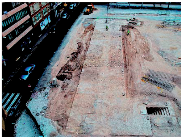
Figura 3. Fotografía aérea del exterior del refugio con planta completa de la losa de hormigón. Refugios Plaza Séneca de Alicante (LOZANO OLIVARES Y LUMBRERAS VOIGT, 2015, 372).
