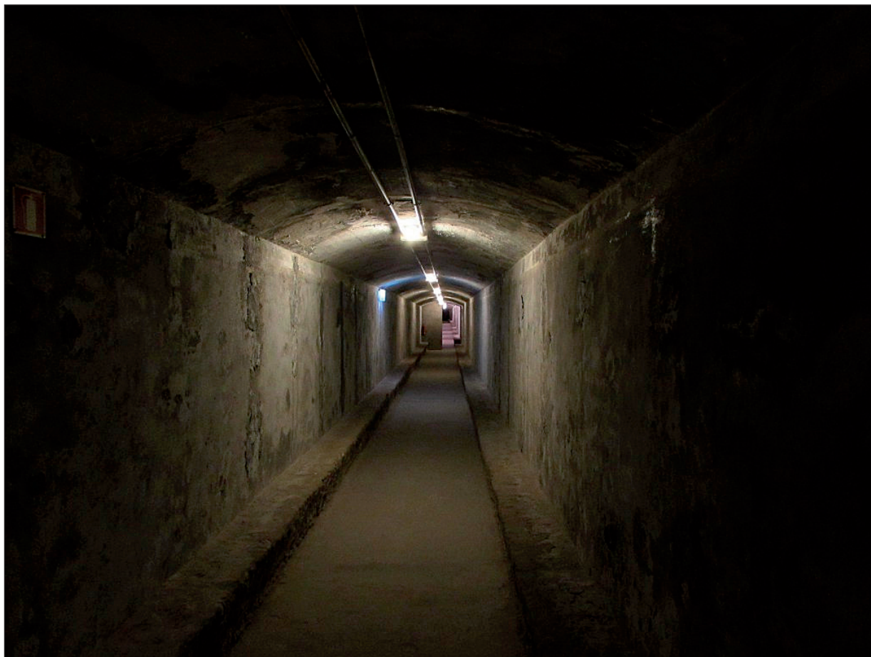
Figura 5. Galería principal de los Refugios subterráneos de Almería. Fuente: archivo de los autores.
