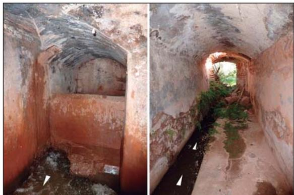
Figura 30. Alberca al-Garsia. A la izquierda la salida del agua de la alberca. A la derecha la galería por la que el agua es canalizada hacia el exterior.
