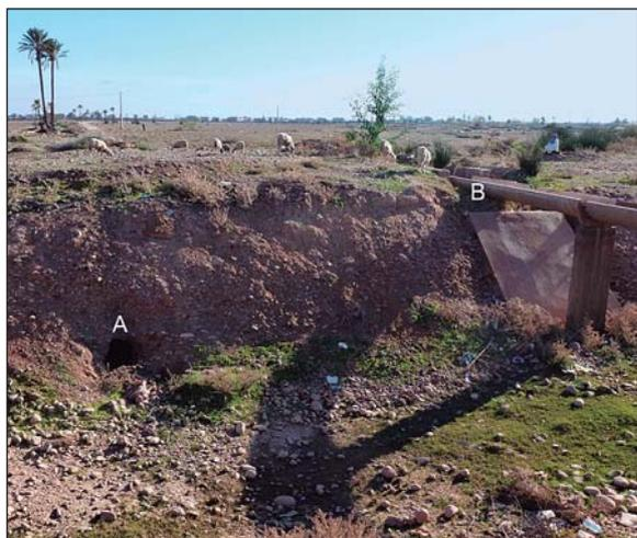
**Figura 18.** Agdal Barrani. Vista desde el norte. Gran canal de evacuación de aguas de escorrentía excavado a mediados de la década de 2000. Jattara seccionada (A) y acequia canalizada para salvar el obstáculo (B).
