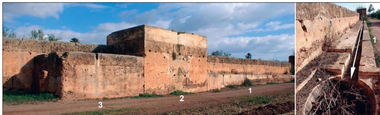
**Figura 45.** Dar al-Hana. Molino occidental: caz (1) que desagua en el cubo; torre adaptada para alojar la sala de molienda (2); área de acceso y zona de servicio (3).
