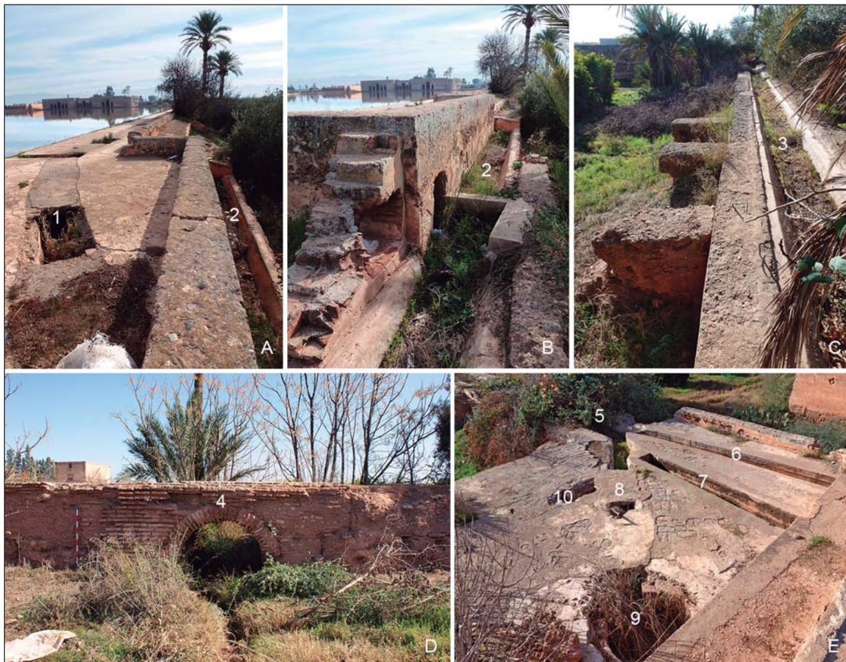
**Figura 54.** Dar al-Hana. Caz del molino septentrional. El agua viene canalizada por los conductos (1 y 2) hasta la esquina noroeste de la alberca, desde donde parte una conducción (3, 4 y 5) que se bifurca en tres: las marcadas con (6) y (7) terminan en una rampa construida en el interior de la muralla, la (8) desemboca en un cubo (9). Un desagüe (10) permite desviar el agua hacia la finca.
