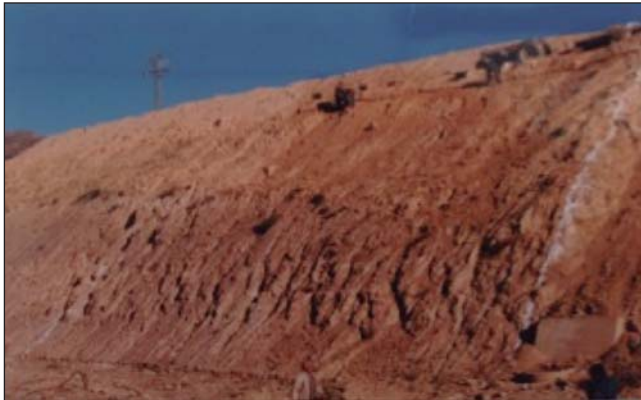
Figura 13. Plantación de líneas de Vetiveria en un talud, Febrero de 1993.
