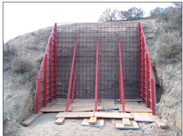
Lámina 11. Cierre y protección de la estratigrafía del Corte 3C-E.
