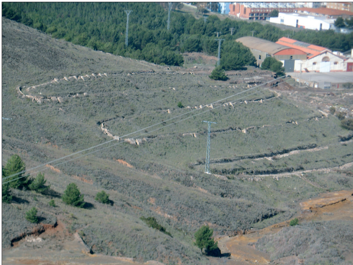
Figura 5. Serpentin de la Fundición de plomo Trinidad Rentero, en el Parque Minero de La Unión. Autor: OGV.
