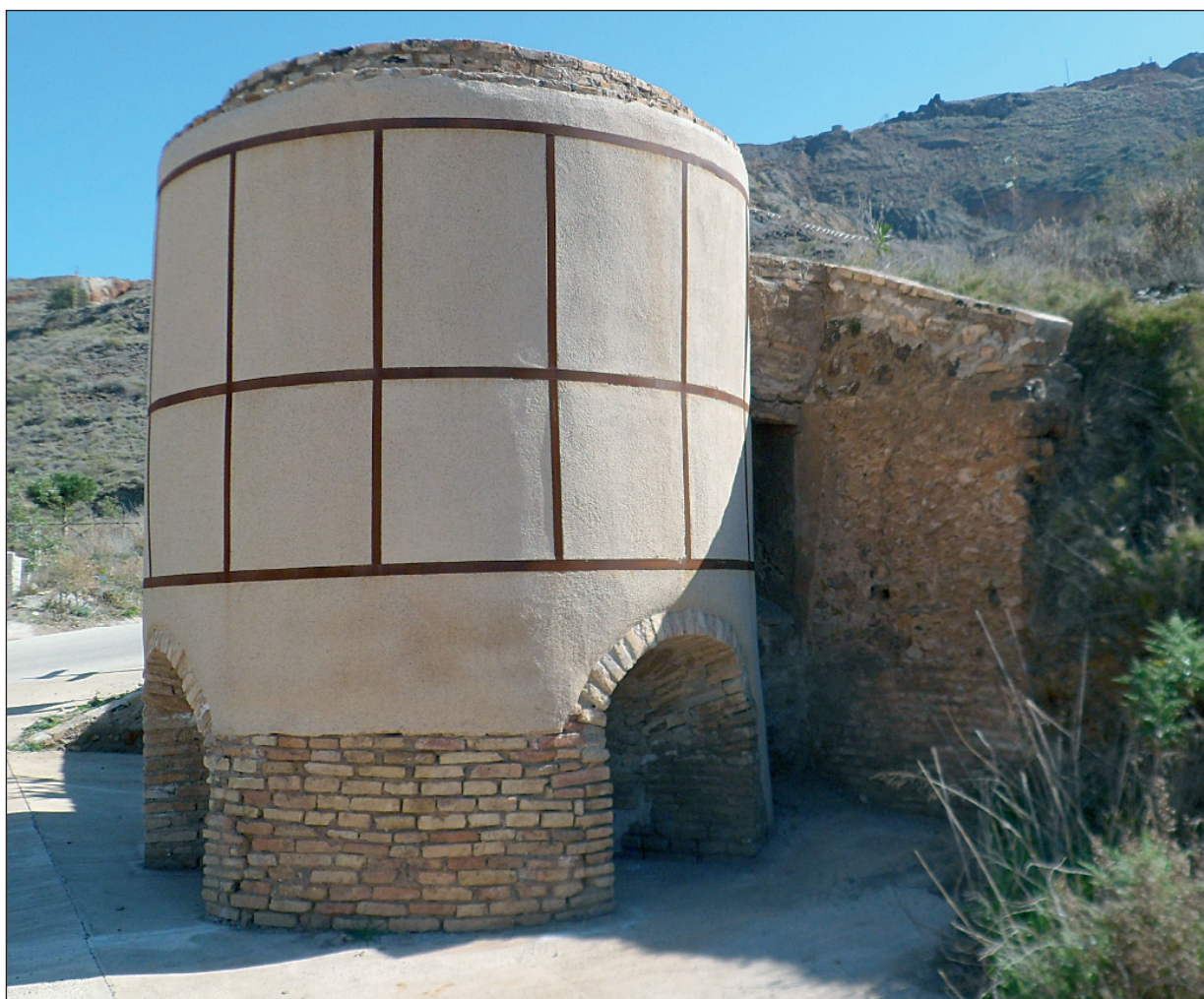
Figura 4. Horno de tostación restaurado. Parque Mínero de La Unión. Autor: OGV.
