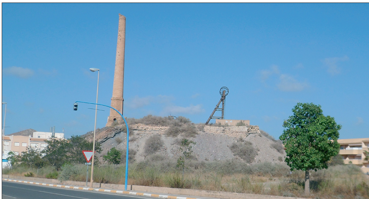
Figura 2. Castillete y chimenea de la Mina Lo Veremos Nuevo. Autor: OGV.
