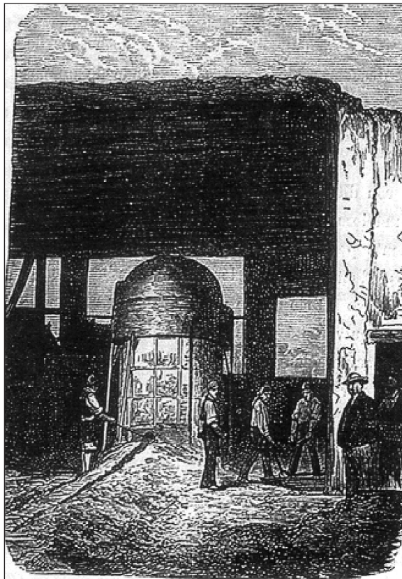
Lámina 6. Horno de viento forzado. F. Botella y Hornos (1868).
