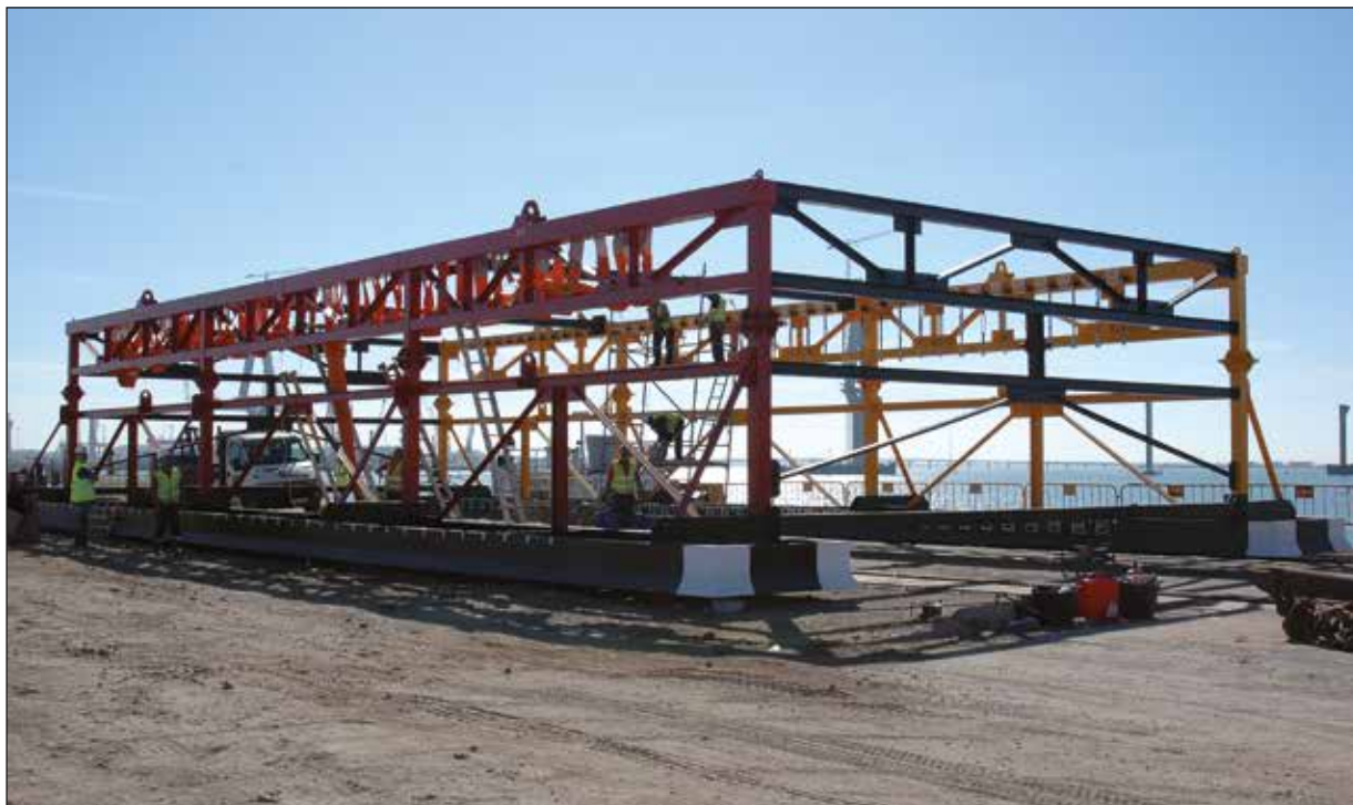
Figura 5. Estructura para el traslado del pecio Delta I. (Fondo gráfico IAPH. Autora: Carmen García).
