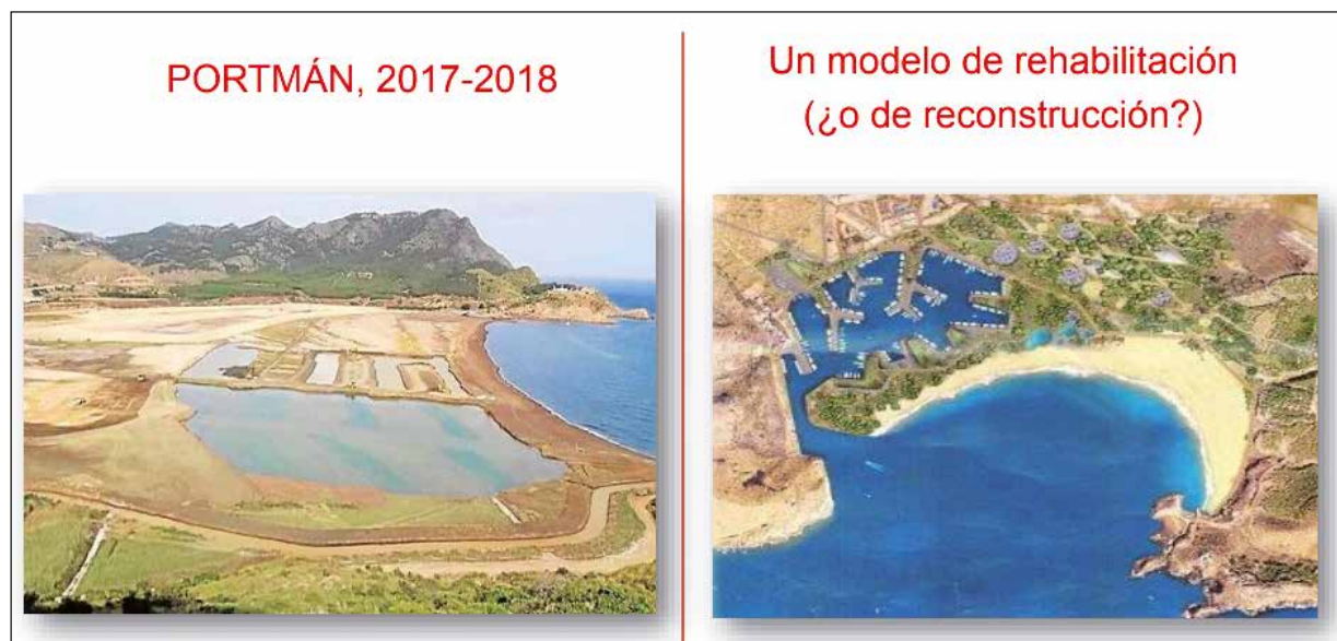
Figura 2. Portmán durante las obras de 2018 y proyecto final. Fuente: Diario La Verdad de Murcia.
