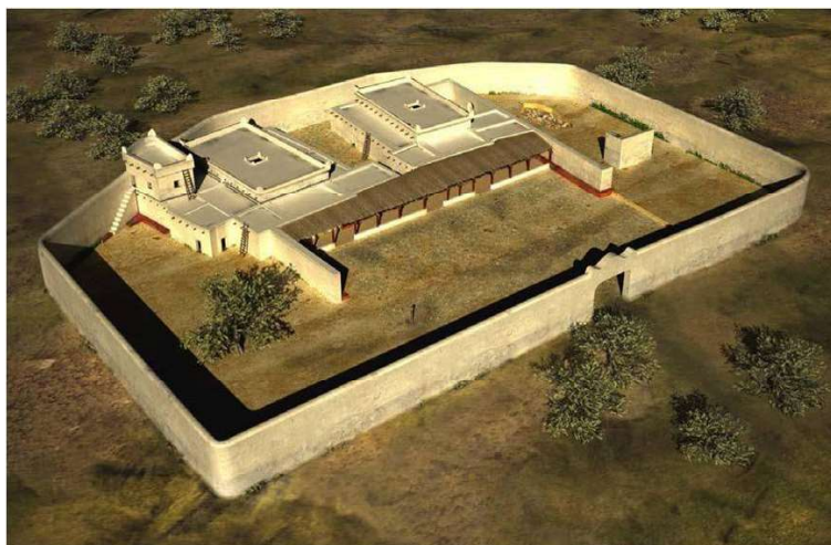
Figura 3. Reconstrucción virtual de El Carambolo III, fase en la que se colmató la fosa interpretada como “fondo de cabaña” (Escacena y Amores, 2011: Fig. 4).
