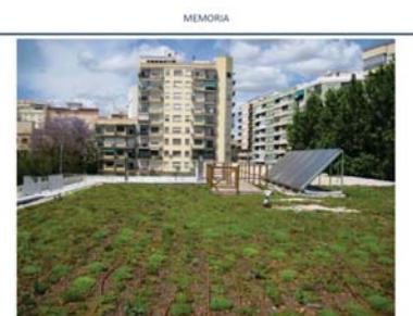
Figura 44. Cubierta vegetada en la azotea del colegio Gonzales Vera en el municipio de Xàtiva (Valencia). Proyecto AQUAVAL.
