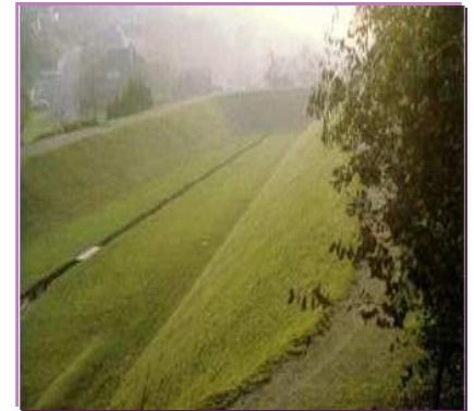
Depósitos de detención
