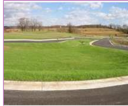
Balsas de infiltración
