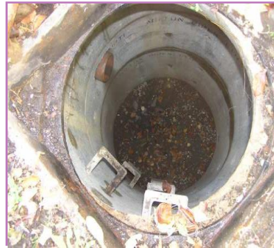
Pozos de infiltración
