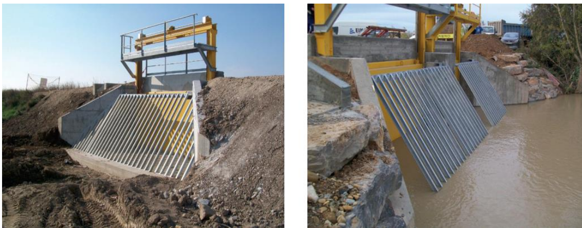
Ilustración 49 Zona de inundación controlada. Compuertas. Pina de Ebro (izq.) y Novillas (dcha.)
