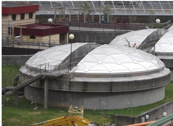
Ilustración 3: Flotador cubierto en la EDAR de Galindo [8]
