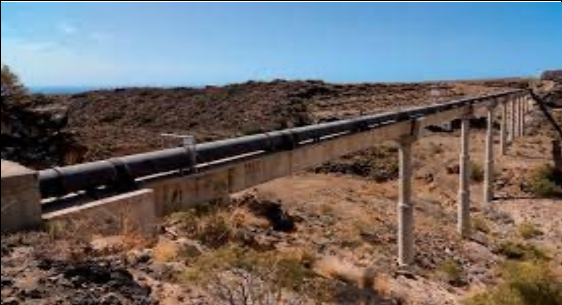
Red transporte agua regenerada –Tenerife, 60 km-
