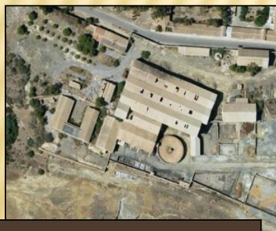
Planta de proceso- Portman
