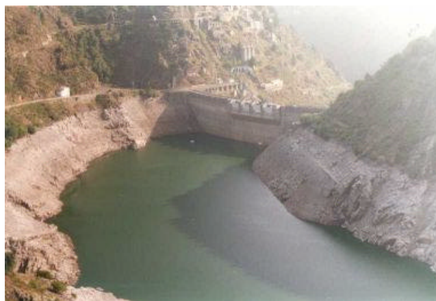
Foto 1: Embalse de Salime, sobre el río Navia (Asturias). Se aprecia fácilmente el flujo del agua desde la cola a la presa, en el sentido del valle. También es visible la zona sin vegetación ("ceja") a causa de la variación de los niveles embalsados. El color verde del agua se debe a la presencia del fitoplancton, que se ve favorecido por la eutrofización y por los bajos niveles de agua que presenta el embalse en el momento de realizar la fotografía.
