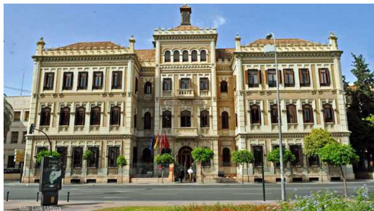
Fachada principal del Edificio La Convalecencia, Sede del Consejo Social de la Universidad de Murcia, junto al Rectorado de la Universidad.
