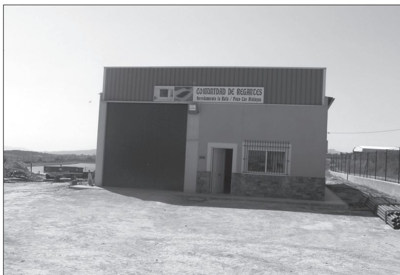
FOTO 5: SEDE DE LA COMUNIDAD DE REGANTES DE LA RAFA/POZO ATALAYAS, RECIENTEMENTE CONSTRUIDA.
