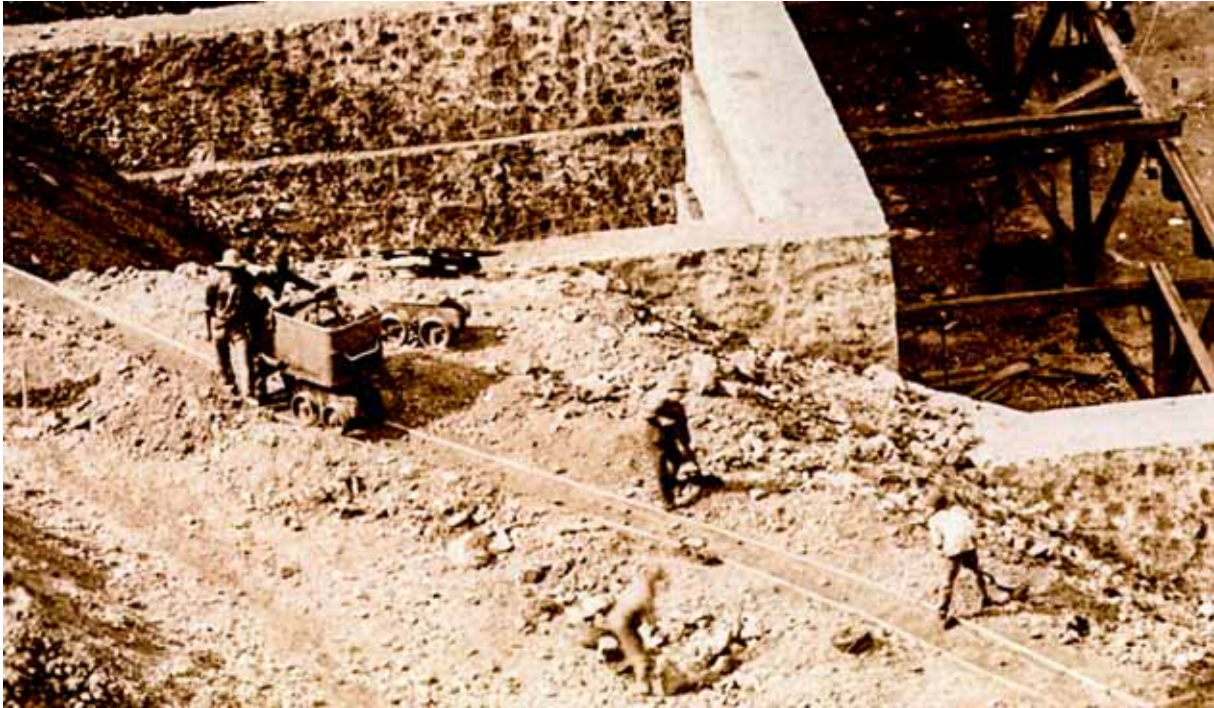
Labores de mantenimiento
