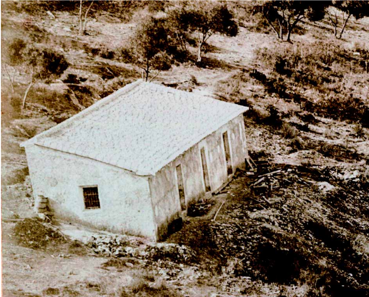
Almacén y herrería
