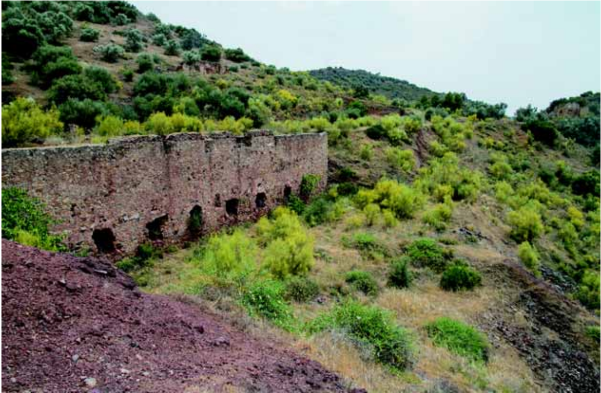
Estado actual del cargadero e inicio del cable aéreo
