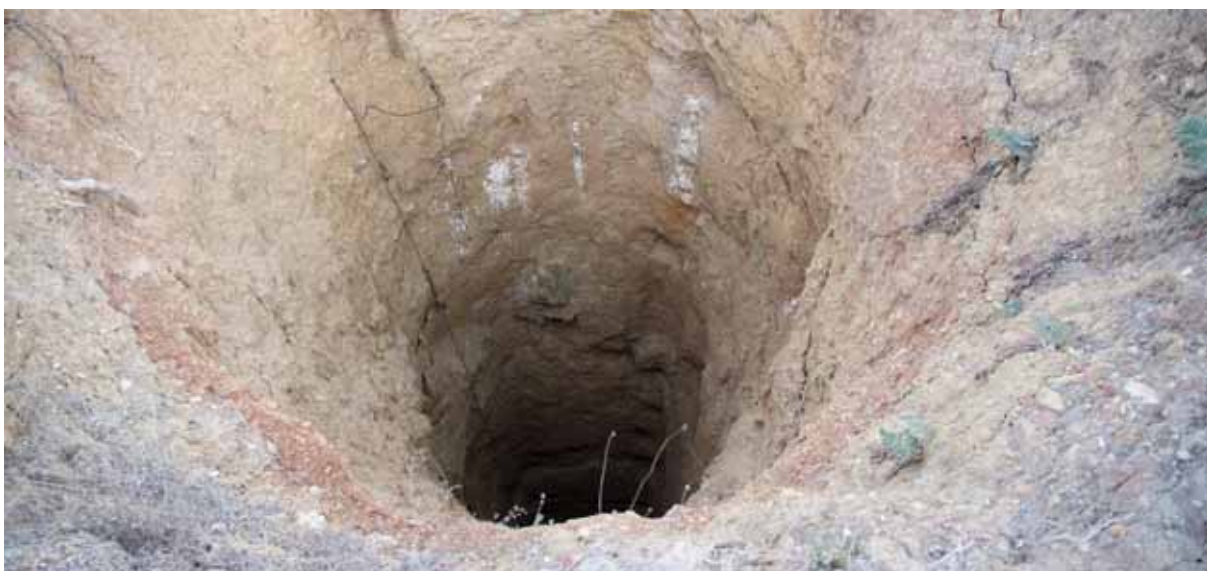
Pozo de ventilación
