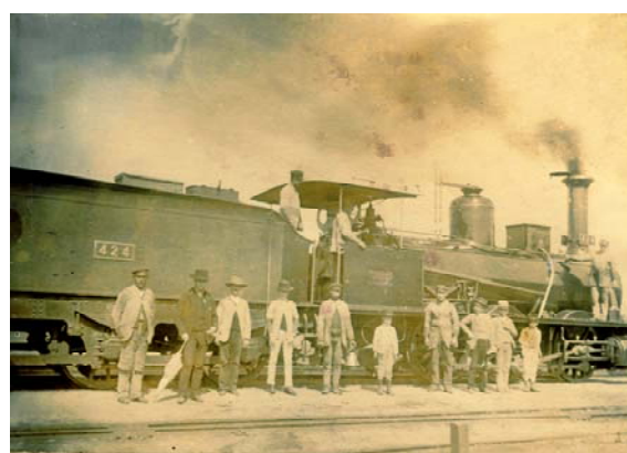
Ferrocarril de la línea de Pozo Ancho (1888) Postal Neufville AHML-FFDA 01020471888 Col. CRSB
