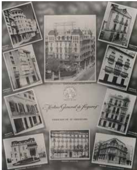
Foto 2.5. Edificios propiedad de la Mutua General de Seguros
